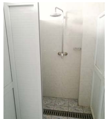
浴室里的隔断、水槽
